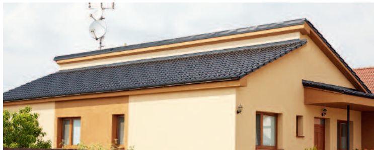
KERAMICKÁ ŠKRIDLÁ. Samba od výrobcu Tondach je moderná kvalitná veľkoformátová krytina. Spojitý systém drážok umožňuje posun až o 25 mm a poskytuje krytine vynikajúce vlastnosti k ochrane objektov pred poveternostnými vplyvmi. Je možné ju klást' na strechy už so sklonom 22° a s poistnou hydroizoláciou dokonca od 12°, preto je možné použiť túto škridlu aj na rekonštrukciu striech s nízkym sklonom.
