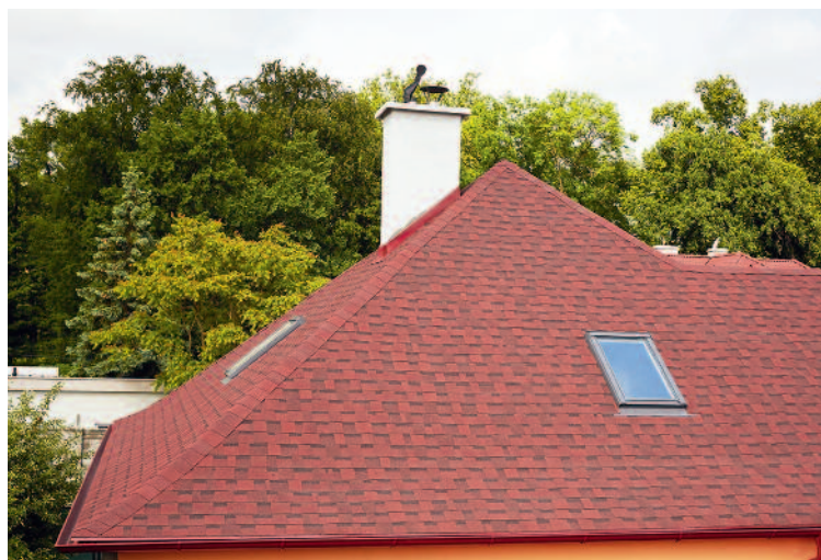
MODERNÝ ŠINDEL. Strecha rekonštruovaná šindľom Cambridge Xpress, čo je najmodernejšia strešná krytina so špeciálne optimalizovanou dvojvrstvou kĺncovacou plochou. IKO Cambridge Xpress je možné použiť už od sklonu strechy 15°, bez rizika podfúknutia. Ako jediný šindel svojho druhu na trhu bol vyvinutý na základe požiadaviek a predstáv spotrebiteľov. Spája v sebe pozitívne vlastnosti strešných šindľov a zároveň vyzerá ako tradičná krytina priestorového vzhľadu.
